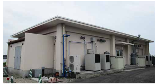
耐候性評価センターの新試験棟
