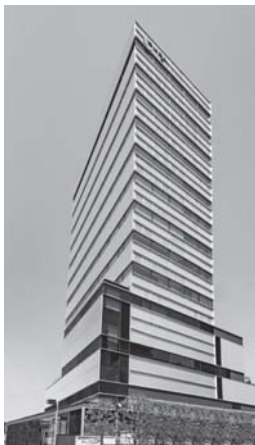
2018年に完成した新しい本社ビル（東京・新宿）
